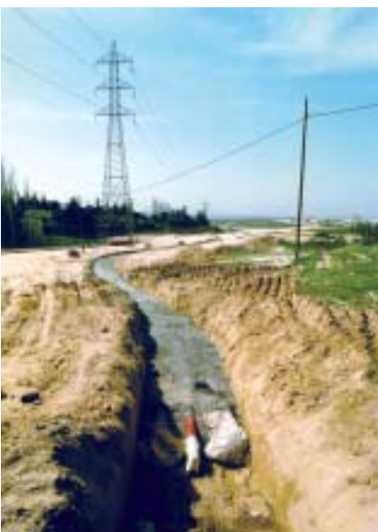
Obras de soterramiento en El Montecillo
